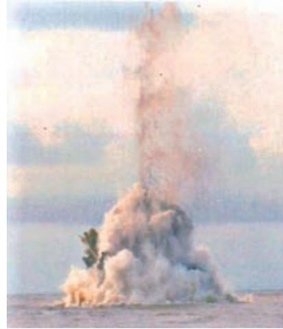
*Démantèlement d'une tête de puits à l'aide d'une charge concentrée*
