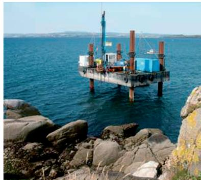
Plateforme élévatrice et foreuse CMV
