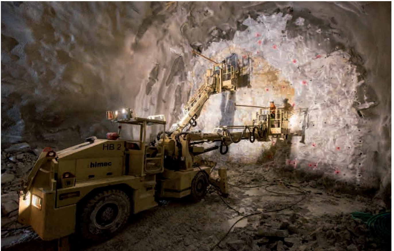
Opération de chargement au front en travaux souterrains
